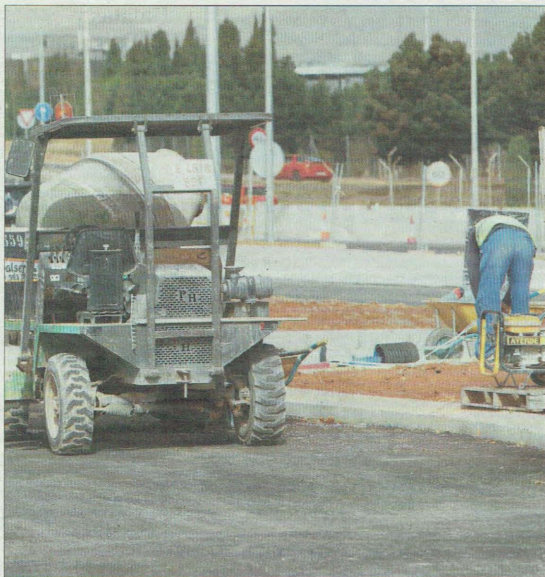
Obras de urbanización del complejo comercial Estepark junto a la ronda de circunvalación. EUGENIO TORRES
