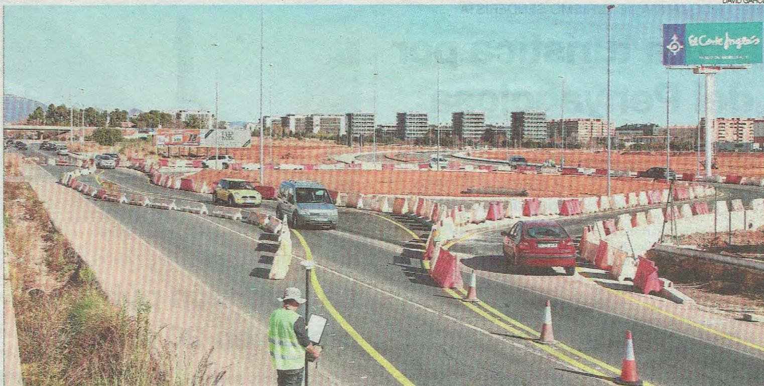
► Imagen de las obras de la rotonda, que durarán un máximo de dos semanas y que obligan a controlar el tráfico.
