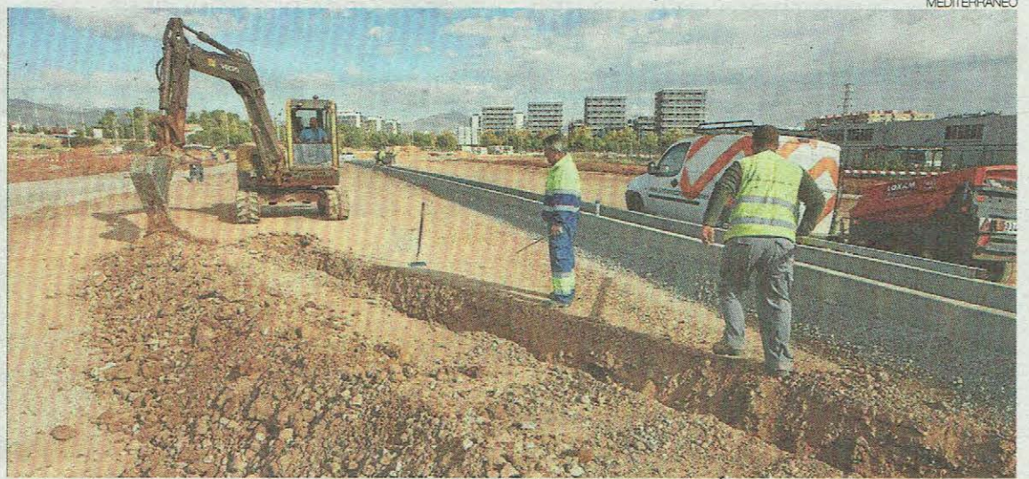
► Trabajos de urbanización en el terreno que ocupará el parque comercial, que se inaugurará en el 2017.
