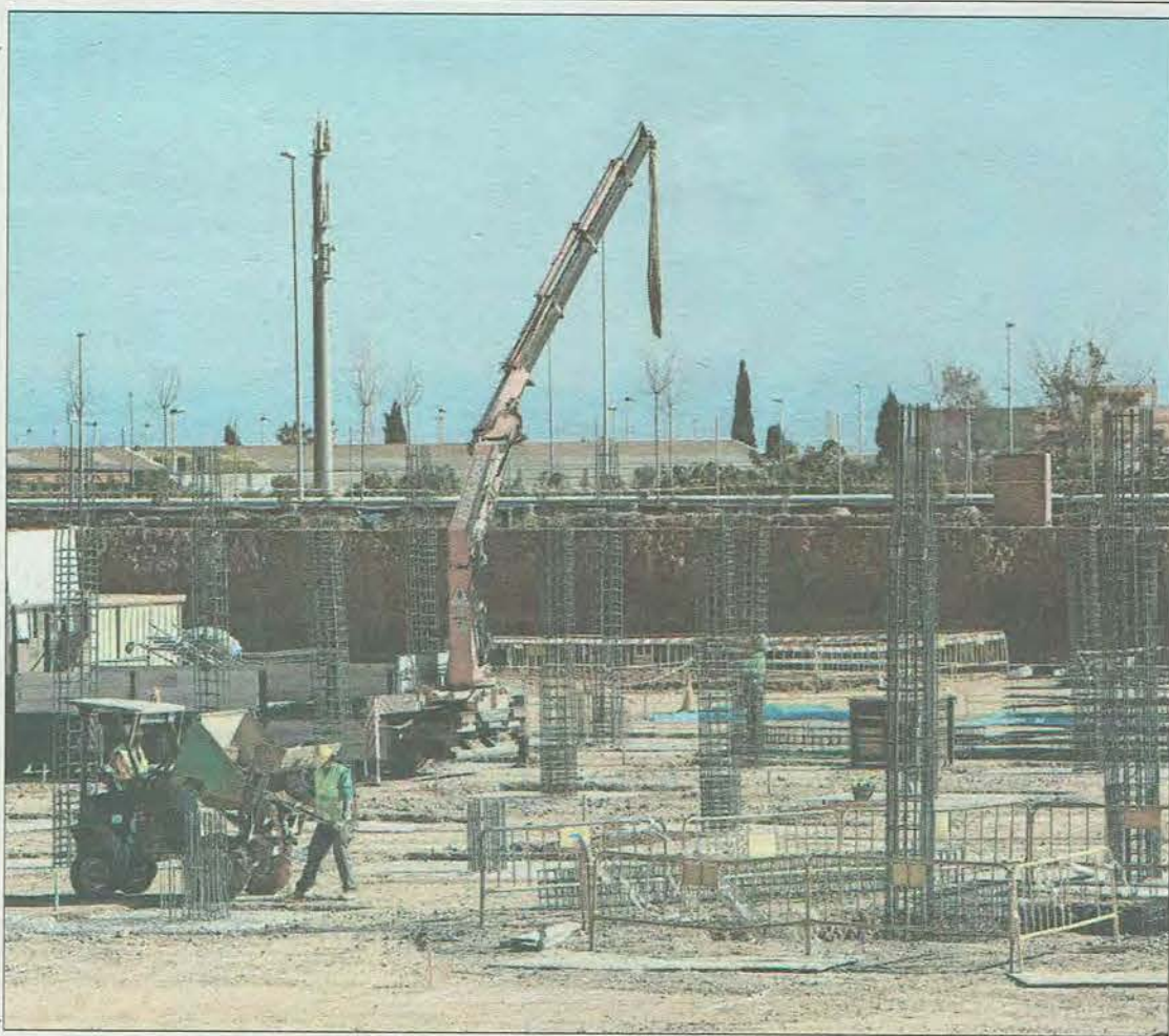
Primeras estructuras del futuro parque comercial. CARMÉ RIPOLLÉS
