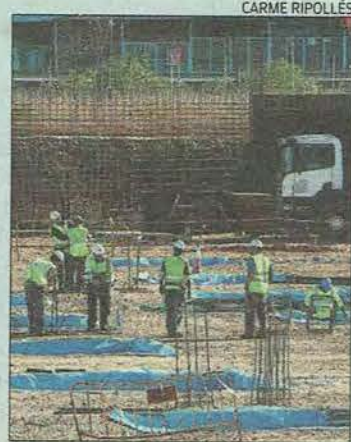
Trabajos ayer en Estepark.
