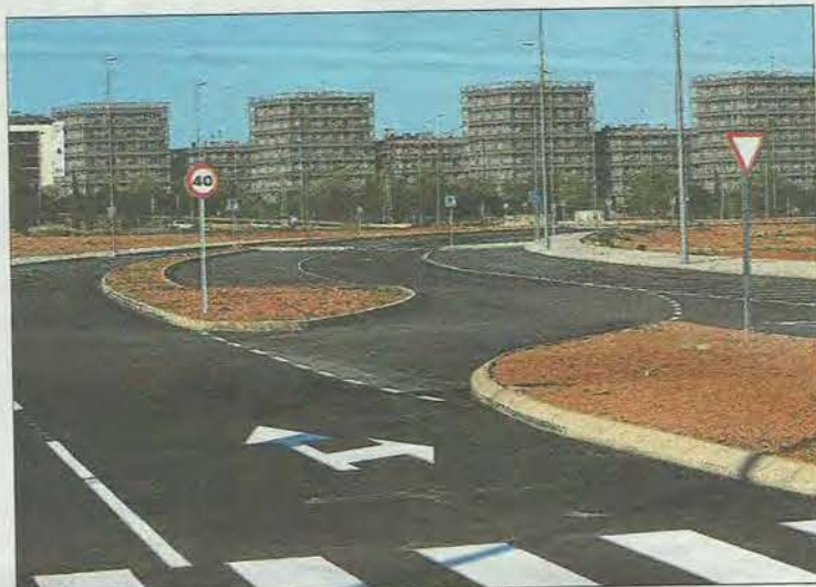
Las obras de urbanización ya han finalizado. CARMEN RIPOLLÉS
