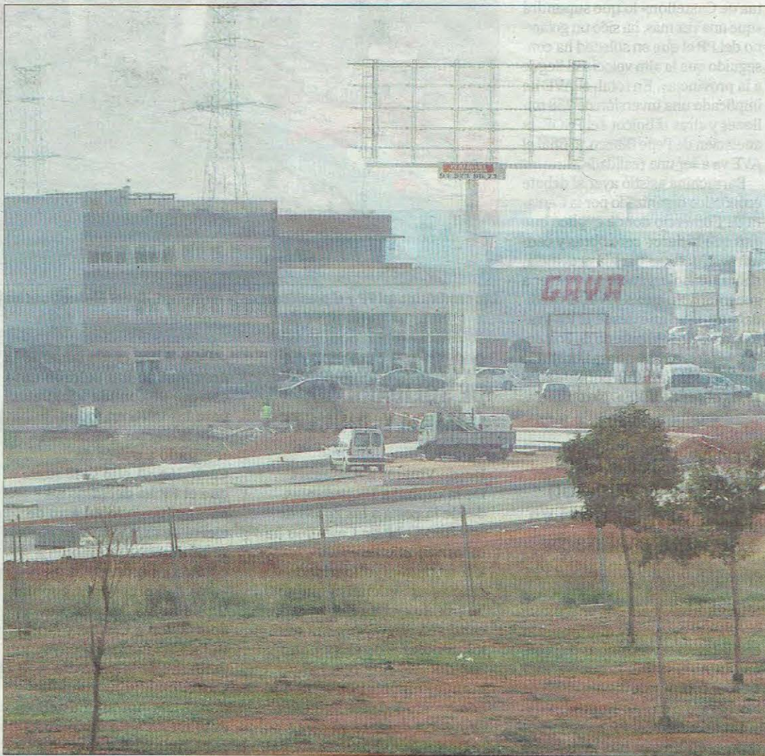
Vista de los terrenos donde se ubicará el nuevo parque comercial, en la zona sur de la capital de La Plana. TORRES
