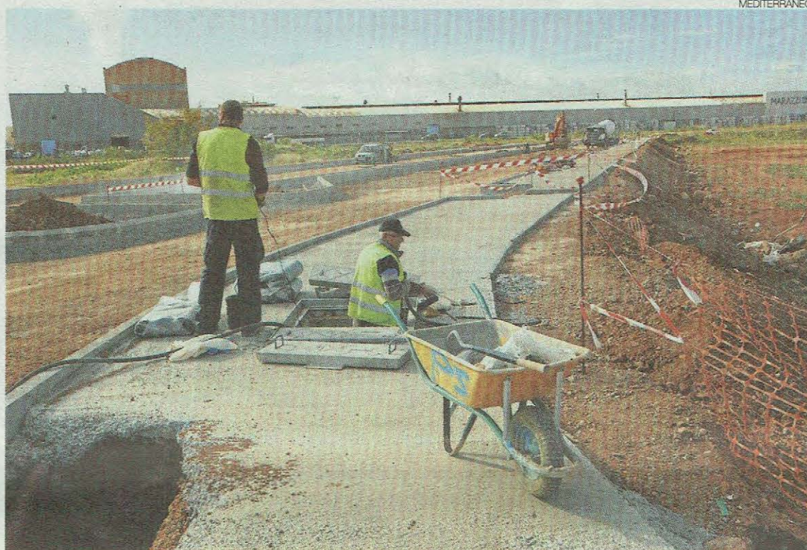
▶▶ Dos trabajadores en las obras de urbanización del parque comercial, que finalizarán en marzo.
