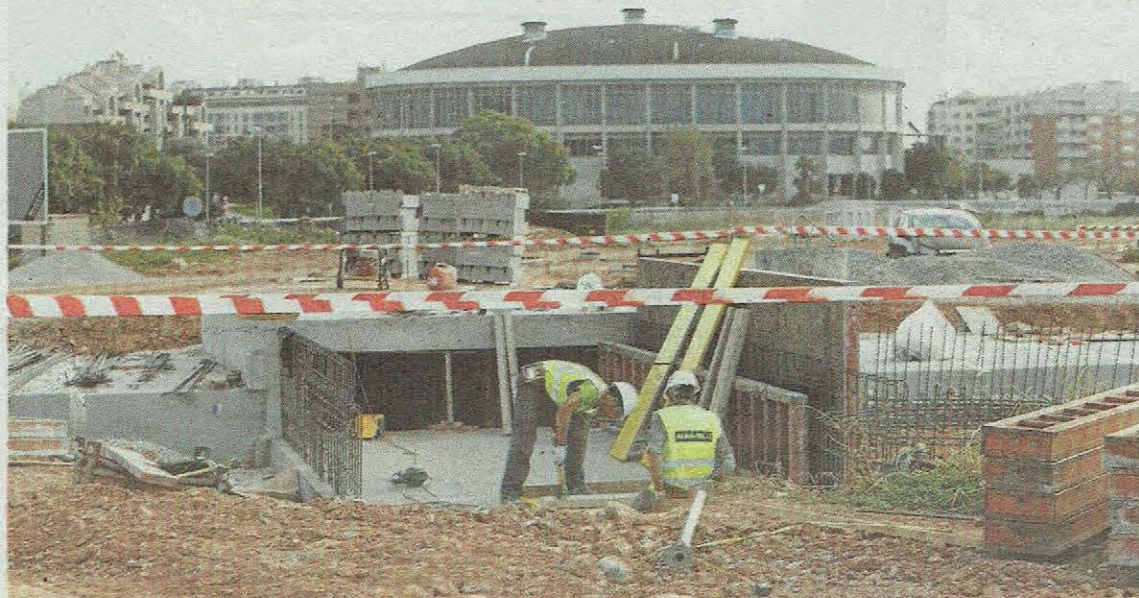
▶ Trabajos de urbanización de la partida Estepar, donde se construirá el nuevo parque comercial.
