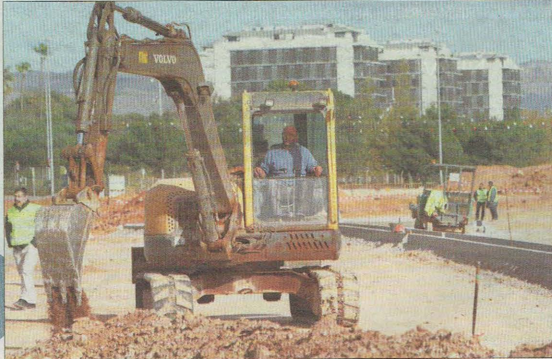
Las obras de urbanización en la parcela donde se levantará Estepark arrancaron el 18 de junio. TORRES
